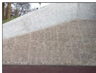
Na behandeling met PVN Epoxyvoeg PVN Epoxyvoeg met Voegsteen
