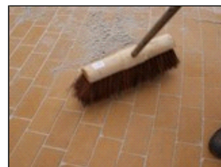
Na behandeling met PVN Epoxyvoeg PVN Epoxyvoeg met Voegsteen
