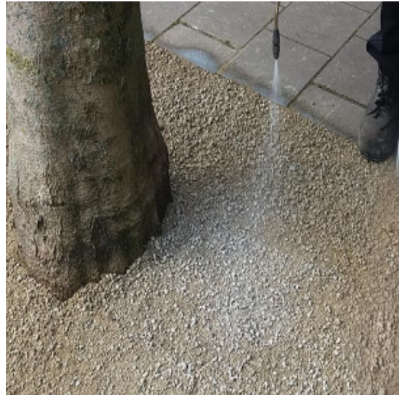
Stap 2 - Aanbrengen van de CitySlim coating
