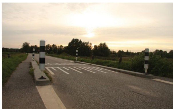
Wegversmalling bij Kekerom
