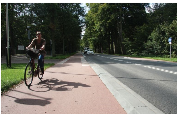
Scheiding van fietspad en rijbaan
