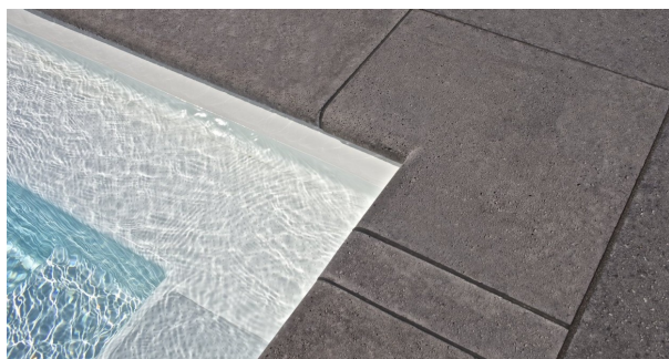
Zwembadomranding met Oud Hollandse betonstructuur (1)
